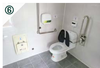
⑥ 남자 화장실 장애인실 구성 자동물내림 비데 양변기 / 양변기 등받이 장애인용 세면대 안전손잡이 안심비상벨 / 영유아보호의자
